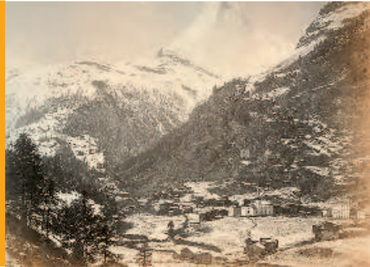
Abb. 4: Zermatt (VS), Hotel Monte Rosa. Das seit 1855 durch Alexander Seiler zum Steinbau umgebaute Hotel Monte Rosa in Zermatt stach als Massivbau deutlich aus dem traditionellen Ortsbild hervor. Älteste bekannte Fotografie um 1860 mit dem Hotel rechts im Bild.
