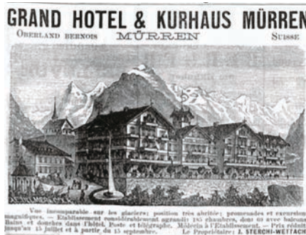
188 Ansicht des Hotelkomplexes von Johann Sterchi-Wettach nach dem Bau des dritten Gebäudes (rechts im Bild).
