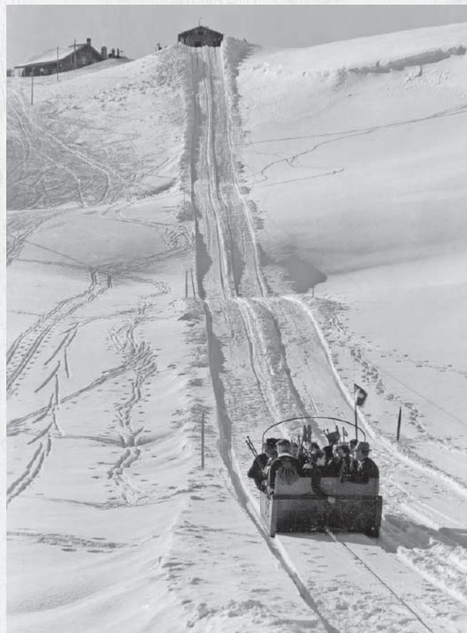
33) Adelboden, Schlittenaufzug Geils-Hahnenmoos, genannt «Fram». Der sogenannte Funischlitten war eine von Arnold Annen aus Laenen bei Gstaad entwickelte Standseilbahn auf Schnee. Der 1935 eröffnete Adelbodner «Fram» stand bis 1954 in Betrieb.
