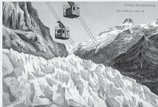
29) Grindelwald, Wetterhornaufzug. Die erste Luftseilbahn der Schweiz nach einem Patent des deutschen Ingenieurs Wilhelm Feldmann wurde 1908 eröffnet. Von den vier geplanten Sektionen entstand nur die erste, die bei Kriegsausbruch 1914 den Betrieb einstellen musste. Ansichtskarte mit einer Fotomontage der beiden Kabinen über dem Grindelwaldgletscher.
