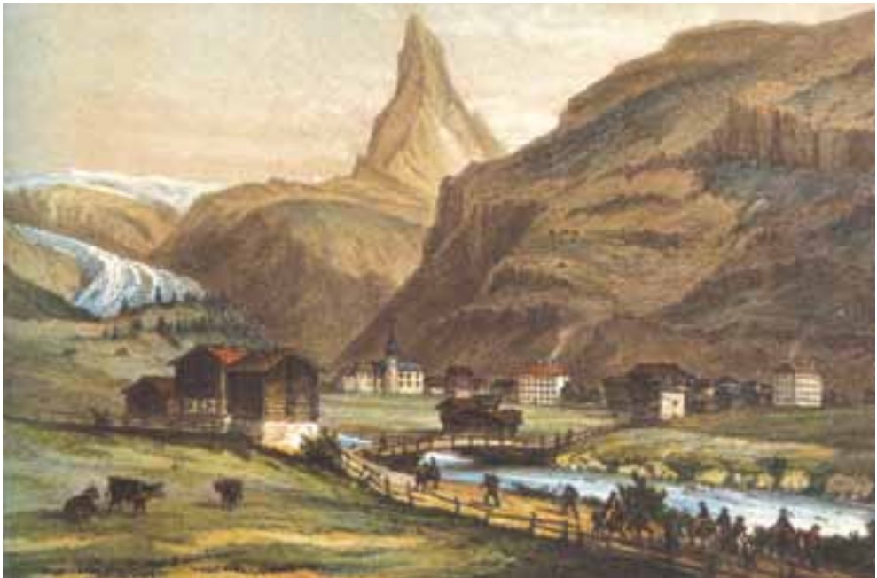
Abb. 6: Zermatt um 1860 mit den beiden steinernen Hotelbauten Monte Rosa (rechts neben der Kirche) und Mont Cervin (am rechten Bildrand) (Sammlung Roland Flückiger-Seiler)
