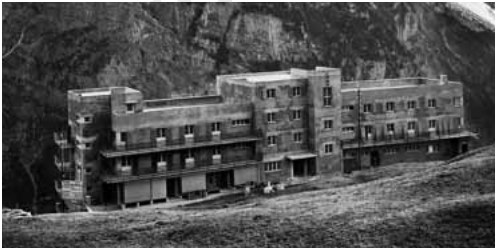
Abb. 16: Das nach einem Großbrand vom November 1926 durch den Thuner Architekten Arnold Itten (1900–1953) neu erstellte Doppelhotel Alpina-Edelweiss gehört zu den ganz wenigen, in der Zwischenkriegszeit erstellten Schweizer Hotels im Stil des Neuen Bauens. Fotografie kurz nach Bauvollendung 1927 (Sammlung Daniel Wolf, Bern).
